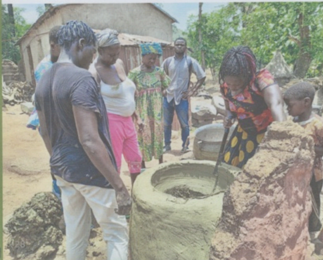
Construction d'un four amélioré qui limite la déperdition de la chaleur et permet d'économiser du combustible : une action du Secaar au Togo.
